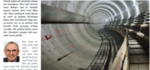
Der neue, gut überdachte und hell erleuchtete Tunnel der SüdStadtBahn.
